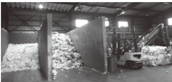
リサイクル施設のストックヤード
