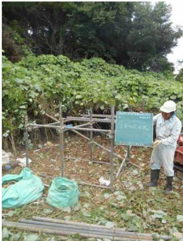
足場仮設状況
