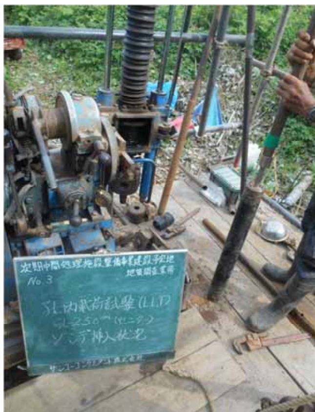
孔内载荷試験(LLT)ゾンデ挿入状況
