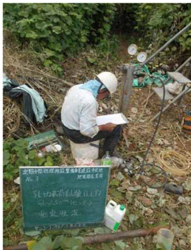
孔内载荷試験(LLT)測定状況 GL- 2.50 m
