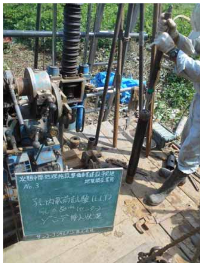
孔内载荷試験(LLT)ゾンデ挿入状況
