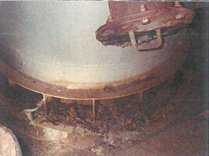
写真 1-03 1号炉煙突内筒ベースプレートおよびサンプリングロ
