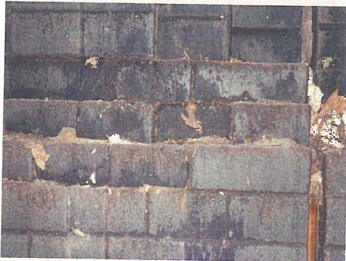
写真 3-02 3号炉乾燥段耐火煉瓦
