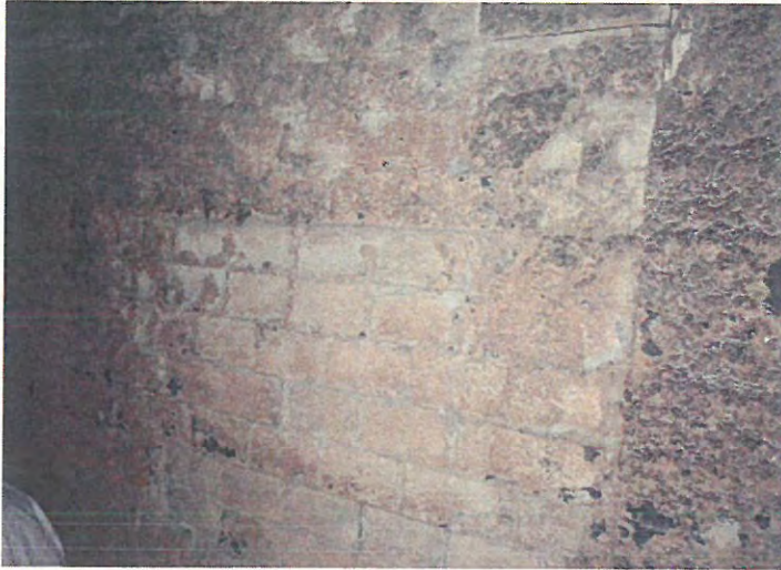
写真 2-02 2号炉燃焼段耐火煉瓦
