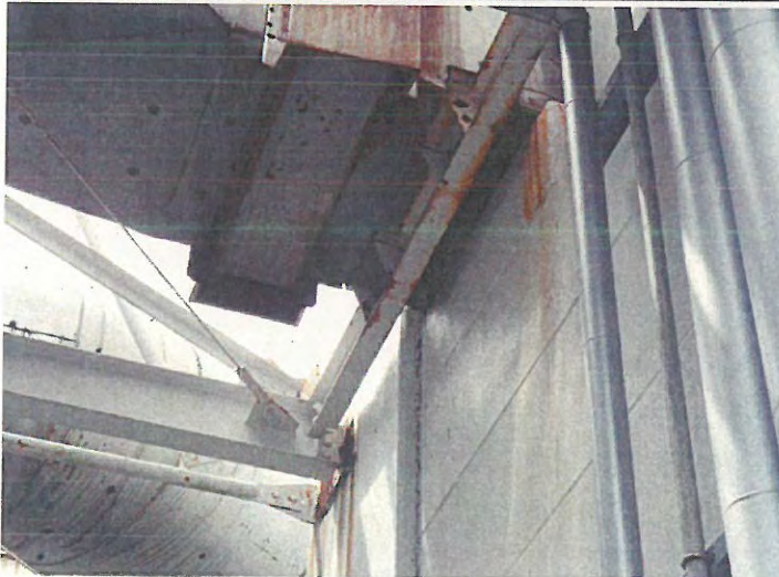
写真 2-06 2号炉煙道煙突入口 エキスパンション
