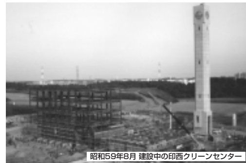
昭和59年8月 建設中の印西クリーンセンター
