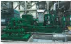
高気タービン発電機
